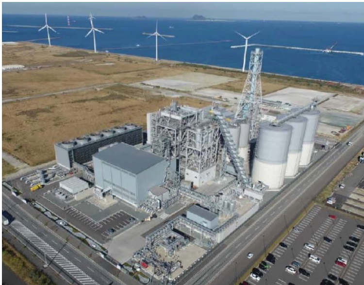
写真1 ひびき灘石炭・バイオマス発電所 全景（運営会社パンフレットより）
